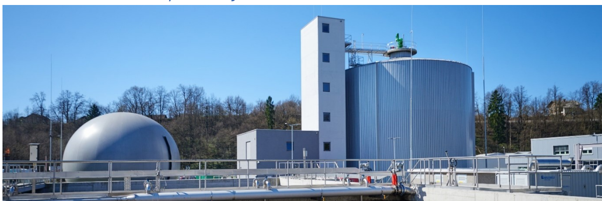
Slika 6: Centralna čistilna naprava Kranj
