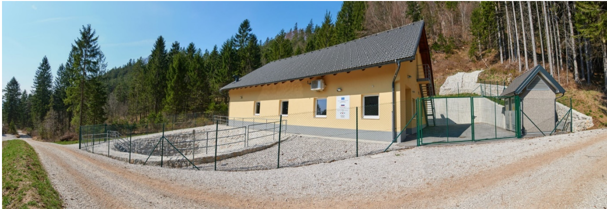
Slika 4: Vodarna Bašelj – objekt v katerem je naprava za pripravo oz. za čiščenje vode, ki priteče iz virov Bašelj kjer se za čiščenje vode uporablja tehnološki postopek ultrafiltracije.
