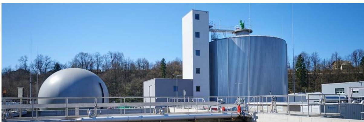
Centralna čistilna naprava Kranj
